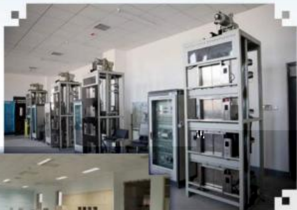
智能电梯安装调试维护训练场所
